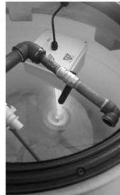
Fije la boyas al tanque con el prensacable provisto, de manera
